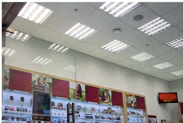
Светильники **CSVT Belluce 595x595** монтируются в подвесные потолки типа «Армстронг». Отражатель крепится к корпусу светильника при помощи скрытых металлических пружин.
