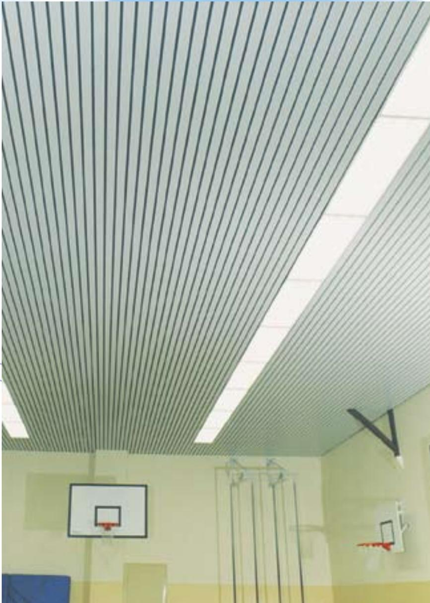
Проверенная прочность для потолков и стен спортивного назначения (с антиударными свойствами)
